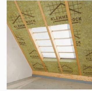
Nichtbrennbare Steinwolle als hoch komprimierte Rolle sorgt für eine auf Maß geschnittene Dämmung zwischen den Sparren. Foto: ROCKWOOL
