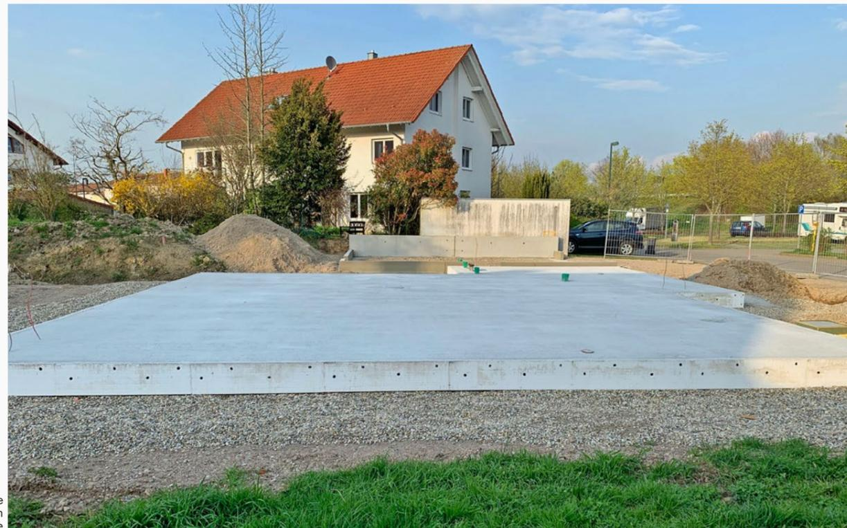
Die Erdgeschoss-Bodenplatte aus Stahlbeton ist die Alternative zum Keller. In beiden Fällen sollten Bauherren auf hohe Qualität achten. Foto: GÜF/Bürkle
