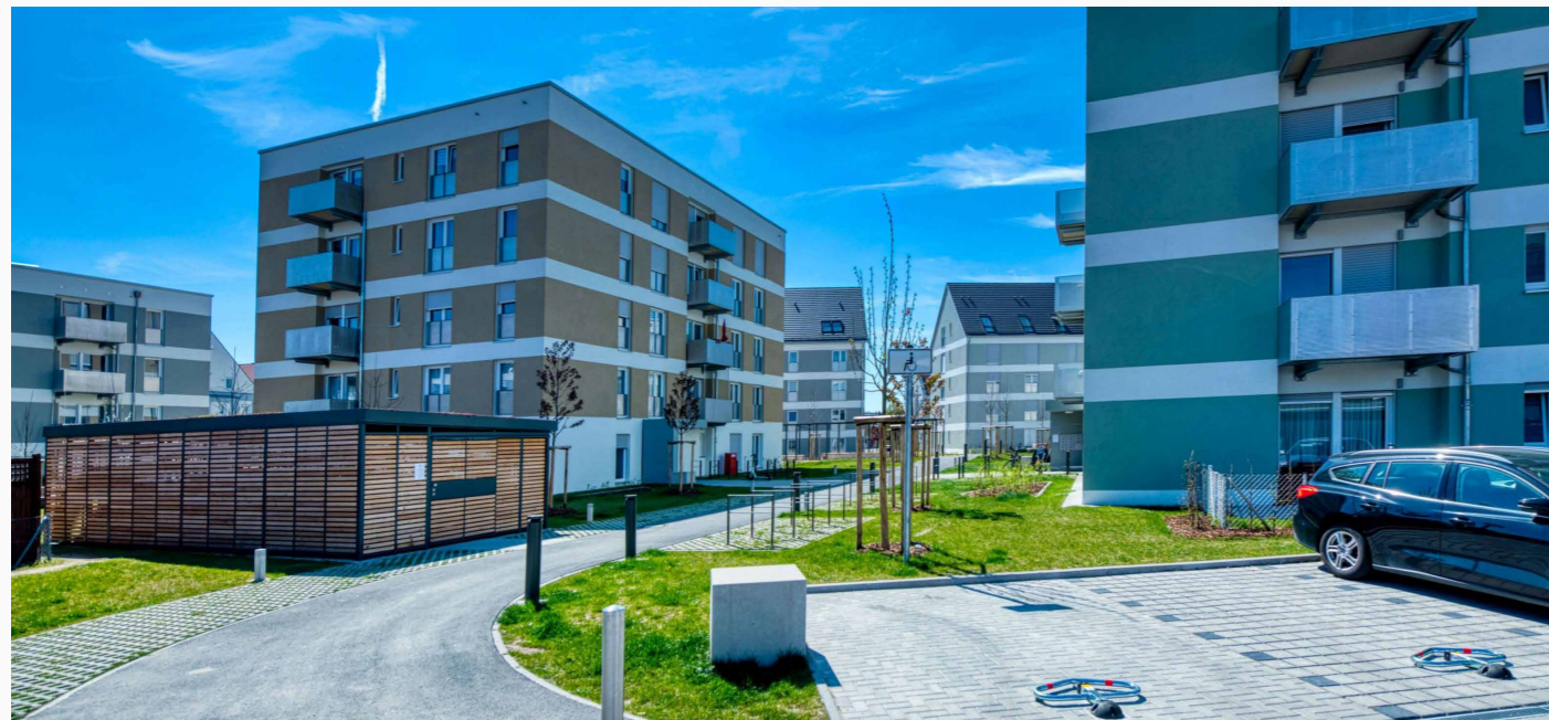
Blick auf die fertigen Wohnungen Am Röthenbacher Landgraben. Hier entstehen 193 Mietwohnungen.
