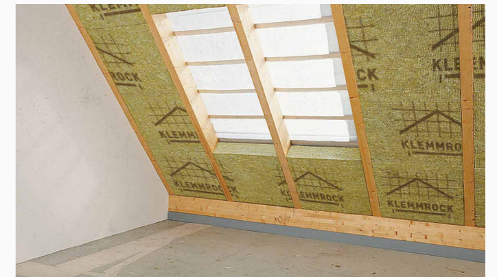
Nichtbrennbare Steinwolle als hoch komprimierte Rolle für die auf Maß geschnittene Dämmung zwischen den Sparren. Bildquelle: Klemmrock
