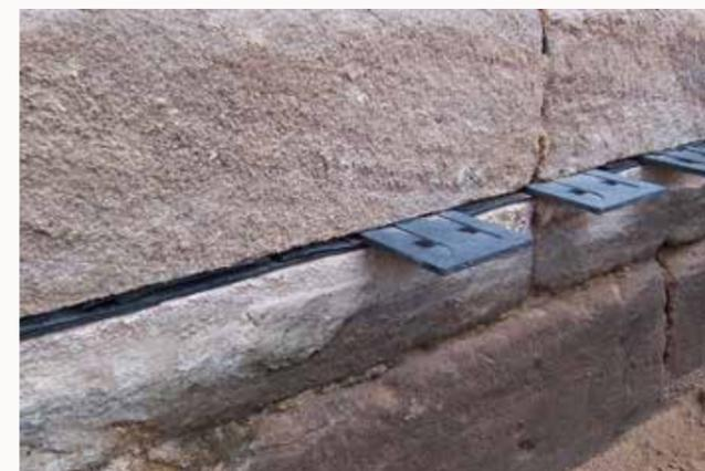
Um das Mauerwerk trocken zu halten, wird bei Neubauten heutzutage eine Sperrbahn eingeplant. Für Altbauten gibt es verschiedenen Verfahren das Mauerwerk nachträglich zu schützen.
