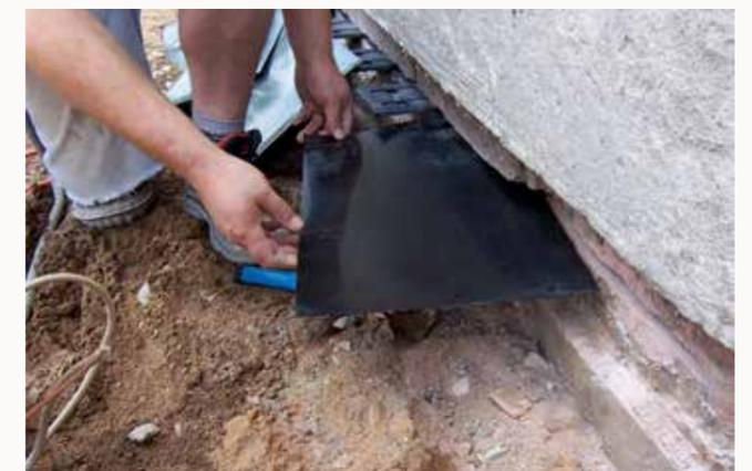
Eine Sperrbahn verhindert dauerhaft, dass Feuchtigkeit aufsteigen kann und hilft so langfristig eine gute Bausubstanz zu erhalten.
