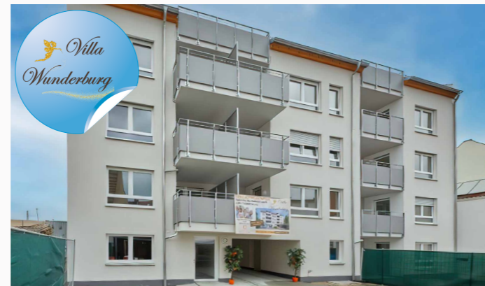
Die Villa Wunderburg in Bamberg Bildquelle: URBANBAU
