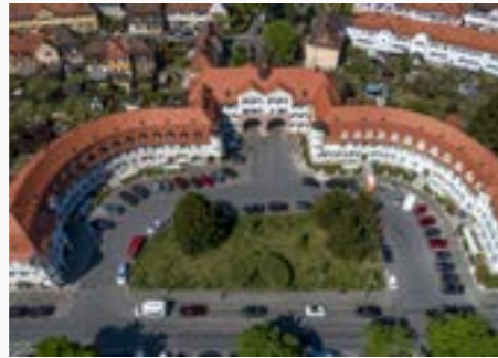
Das Ensemble in der Werderau wurde umfassend saniert und erstrahlt nun im neuen Glanz. Foto: Oliver Heint
