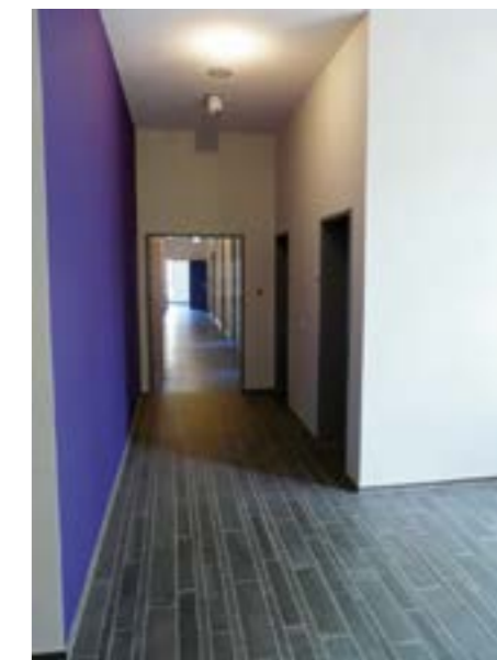
Selbst wenn auf diesem Flur reges Treiben herrscht hält sich die Lärmbelastung in Grenzen, denn der Gussasphaltuntergrund sorgt für eine maximale Trittschalldämmung. Foto: epr/bga Beratungsstelle für Gussasphaltnwendung e.V.
